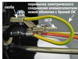
4 Электрически соединить штуцеры узлов вводов ОК внутри
