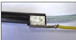
3) Подключить перемычку, соединенную с алюмополиэтиленовой оболочкой, к кронштейну кабельного ввода. Освободить от изоляции конец провода перемычки на длине 20 мм, загнуть оголенную жилу в виде полупетли и завести под скобу. Закрепить перемычку на кронштейне с помощью скобы, пользуясь отверткой.
