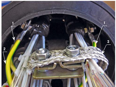
**1** - перемычка соединения брони вводимых в овалный ввод ОК (установлена на шпильки соединителей Scotchlok 4460-D);
