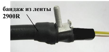
**8.2.6** Установить верхнюю часть соединителя и закрепить гайкой. Наложить на соединитель и на прилегающие к нему участки ОК бандаж из двух-трех слоев ленты виниловой на длине около 10 мм.
