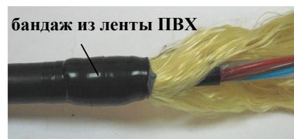
**8.3.4** Продвинуть ОК в патрубок и расположить ОК таким образом, чтобы обрез внутренней оболочки ОК выступал за край патрубка примерно на 5 мм.
