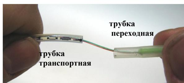
**14.2.3.4** Промаркировать самоклеющимся маркером транспортную трубку, надвинутую на ОМ, в соответствии с нумерацией этого ОМ.
