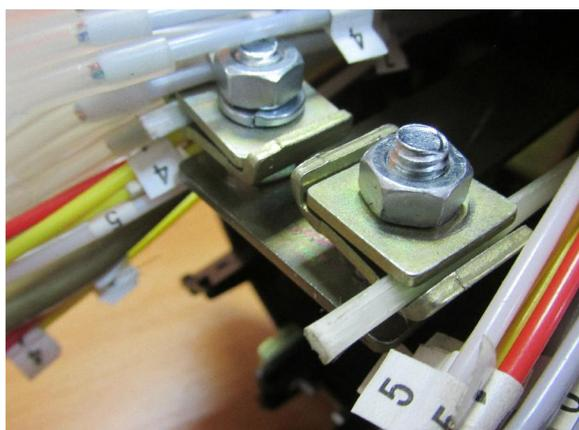
Примечание – Если ЦСЭ представляет собой стальной трос в полимерном покрытии, выполнить электрическое соединение этого ЦСЭ с броней ОК с помощью отрезка ленты-плетенки заземления или перемычки, подключив ленту-плетенку заземления/наконечник перемычки к шпильке узла крепления ЦСЭ (на кронштейне) и к шпильке соединителя Scotchlok 4460-D, установленного на ОК.
