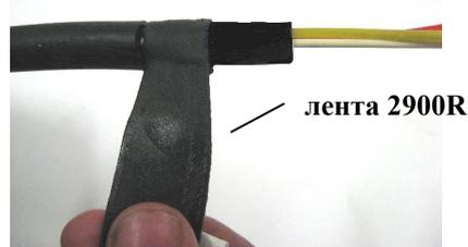
8.2.4 Вставить нижнюю часть соединителя между внутренней оболочкой с наложенной на нее лентой 2900R и наружной оболочкой, под стальную гофрированную ленту.
